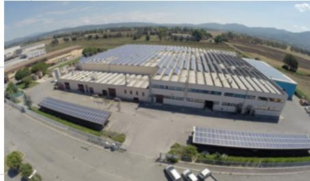
**Impianto fotovoltaico da 200 kW**
