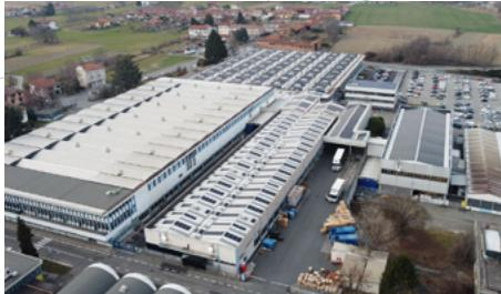
**Impianto fotovoltaico da 384 kW**
