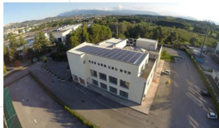
**Impianto fotovoltaico da 188 kW**
