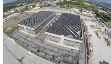
**Impianto fotovoltaico da 20 kWp**
