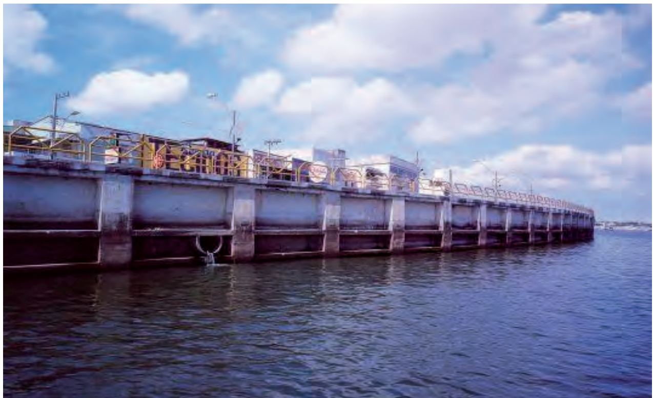
Santarem - PA - BRASILE Strada Av. Tapajos, trattamento delle acque e sbarramento di tenuta idraulica Av. Tapajos road, water treatment and wet seal barrage
