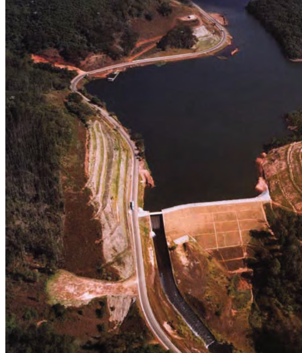
Itabira - MG - BRASILE Diga e spostamento della carreggiata Dam construction and road relocation
