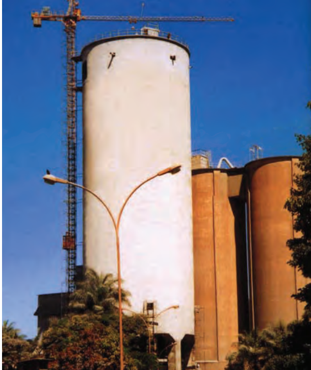
Brasilia - DF - BRASILE Silo multicamera per cemento di 61 m. Multi chamber silo for cement storage 61 mt.
